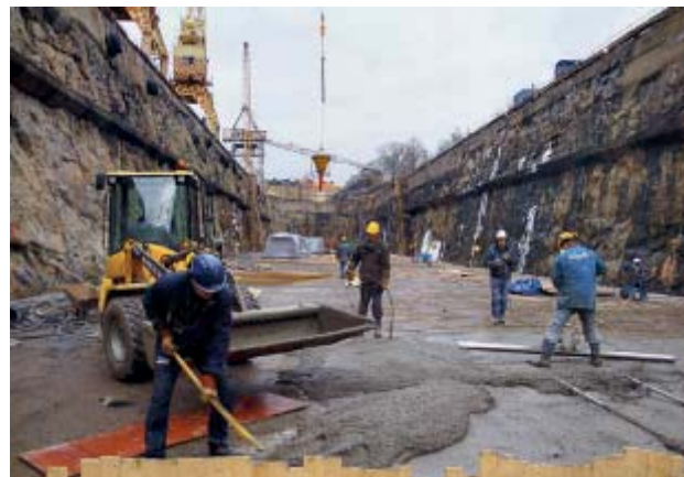
Torrdockan vid Beckholmen repareras och tätas. Foto: Stockholms reparationsvarv.
