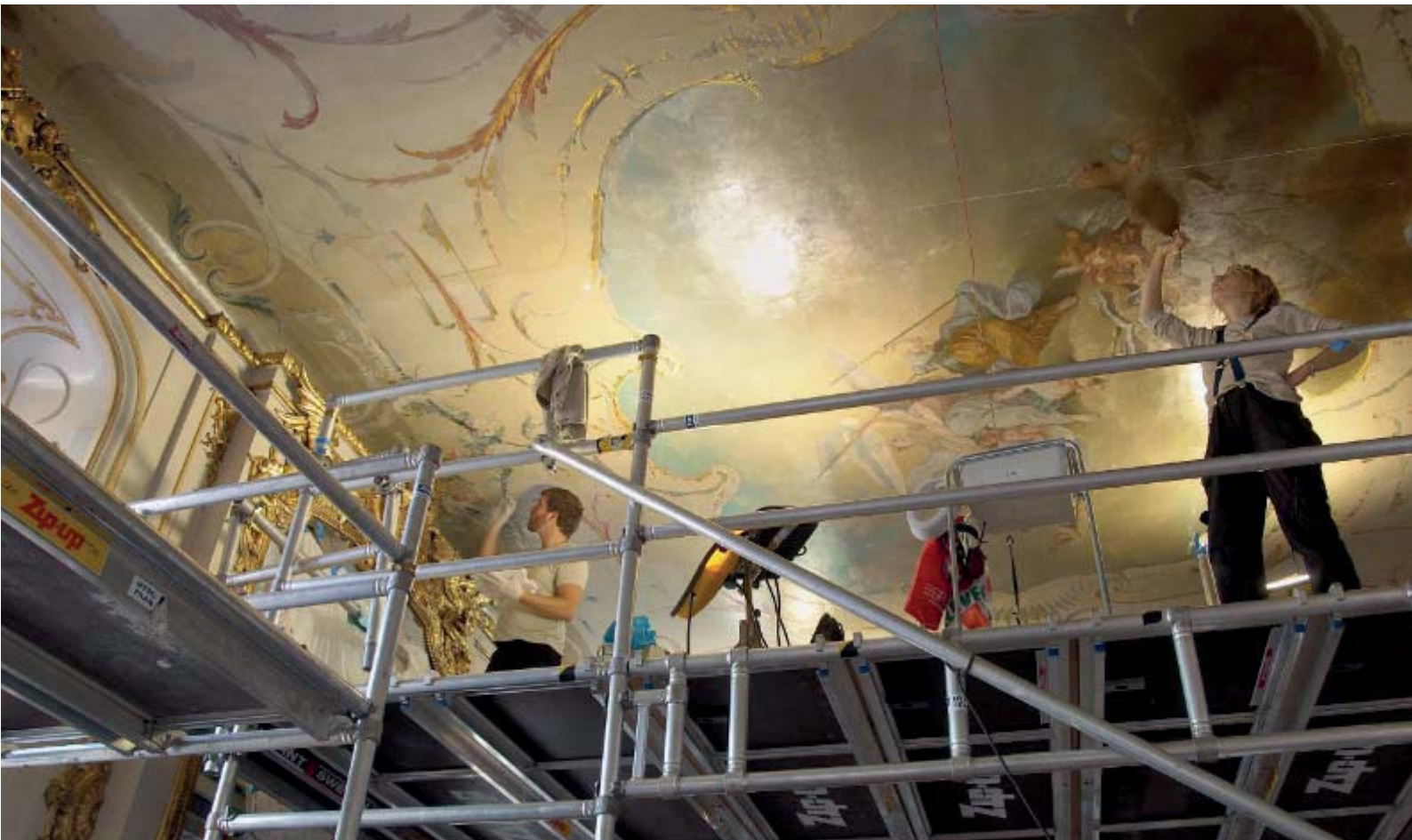
Renoveringsarbeten i Bernadottégalleriet på Kungl. Slottet. Foto: Kungl. Hovstaterna.
